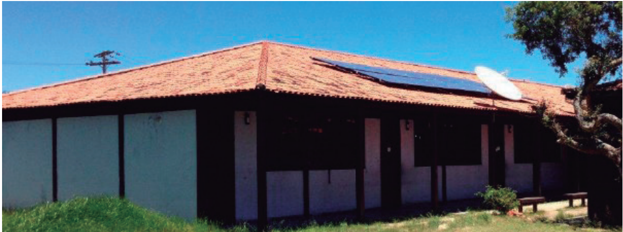
Figura 4 – Instalações Fotovoltaicas em uma Escola Municipal. Fonte: Elaboração Própria
