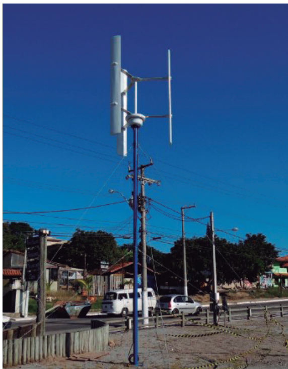
Figura 6 – Instalação de Gerador Eólica no Porto da Barra. Fonte: Elaboração Própria
