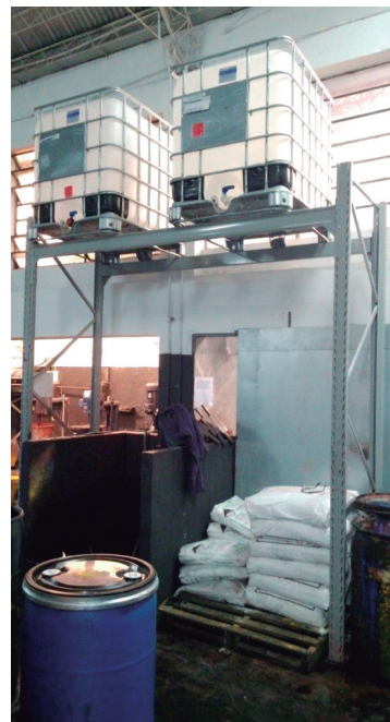
Figura 13 - Container de estocagem de Etanol e Glicol
