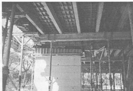
Figura 6 - Detalhes de montagem da laje e da "desfôrma" de lajes. Fonte: Ademar Medeiros.
