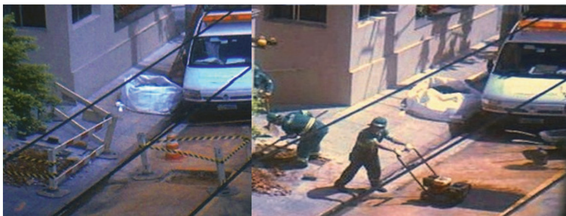
Figura 2 - A interdição da via, abertura da vala e finalização. Fonte: própria, 2007
