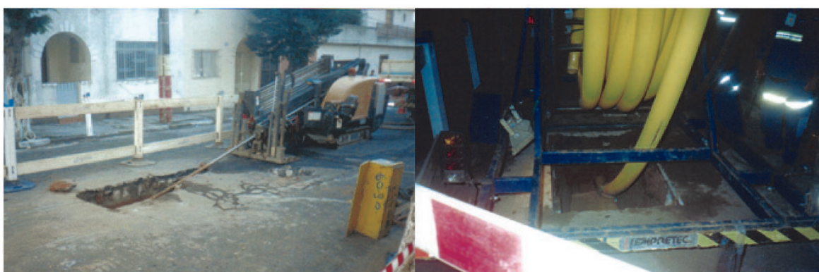
Figura 1 - Perfuratriz rotativa e inserção do duto. Fonte: própria, 2007
