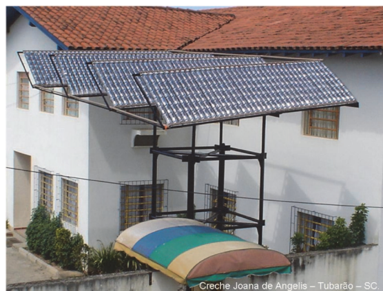
Figura 7 – Sistema de aquecimento construído com garrafas PET. Fonte: José Alcino, 2004
