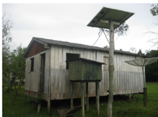
Figura 4 – Painel fotovoltaico – Aiucá-AM. (MORALES, 2014).
