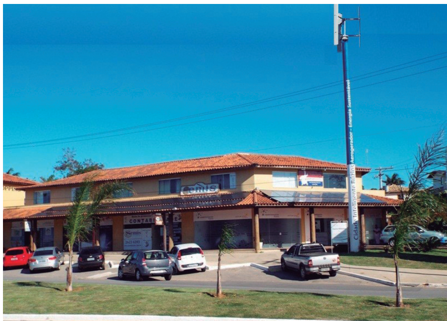
Figura 1 - Instalações Fotovoltaicas e Eólicas no Centro de Monitoramento. Fonte: (FORTES et al., 2014)
