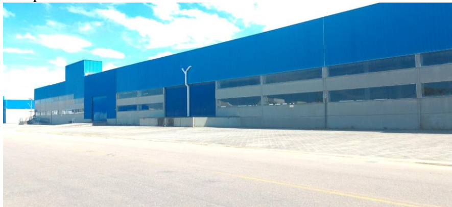
Figura 1. Vista panorâmica externa do galpão.
