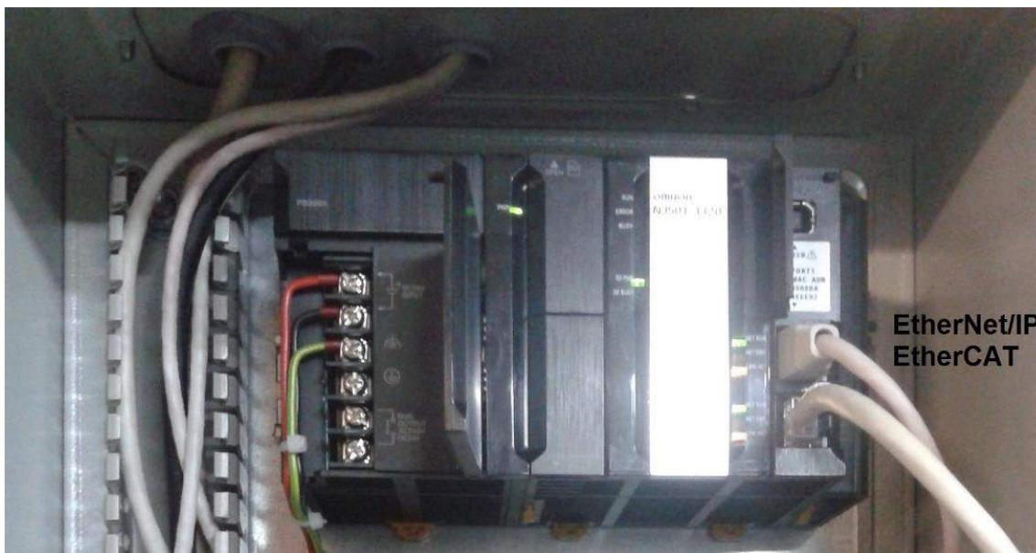
Figura 4. Estrutura física do controlador NJ501-1320
