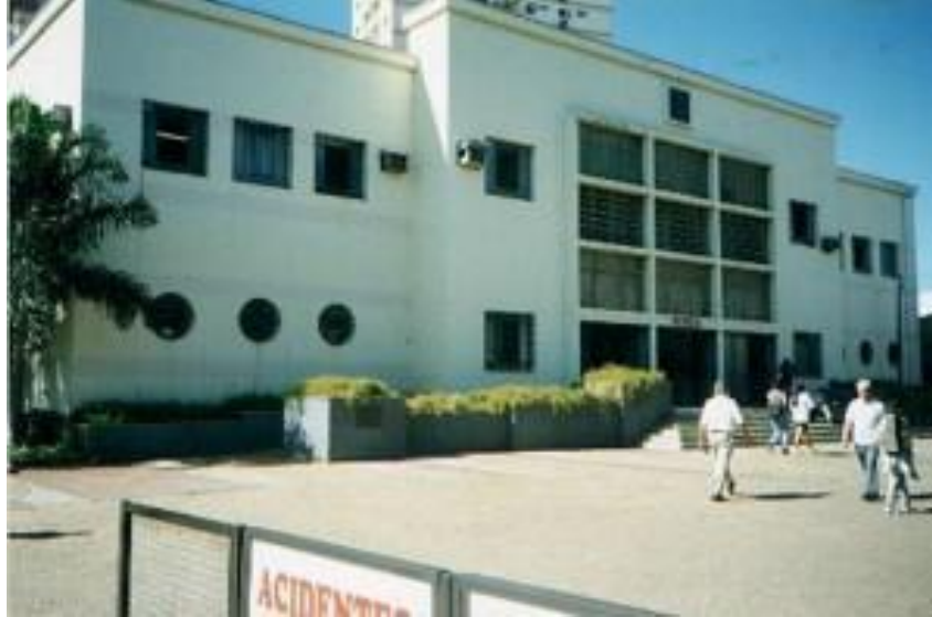
Figura 9 - Prédio da antiga Estação Ferroviária Ituana/Sorocabana
