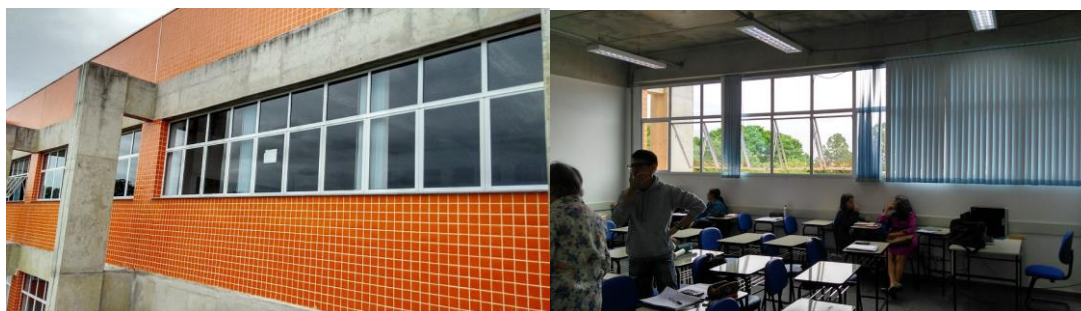
Figura 2 a/b: Vista externa e interna da sala 2
