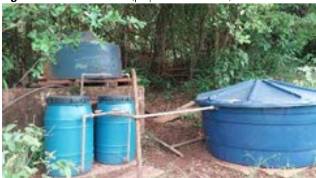
Figura 5: filtro lento de areia (propriedade em Avaré).
