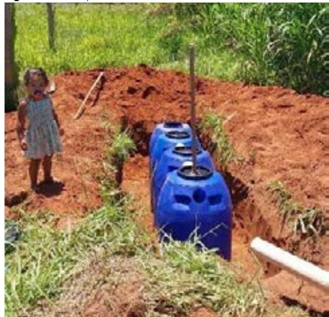
Figura 7: fossa séptica (Assentamento Zumbi dos Palmares).
