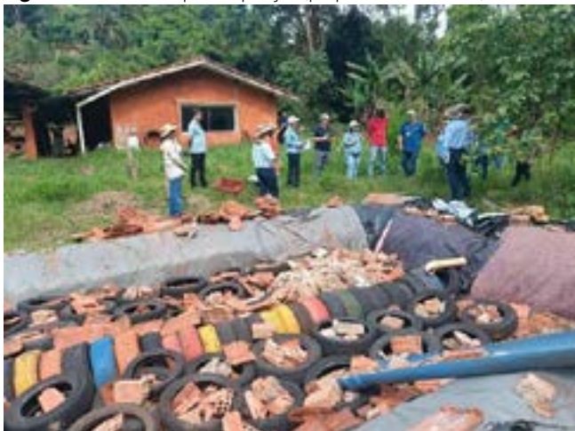
Figura 4: bacia de evapotranspiração (propriedade em Avaré).
