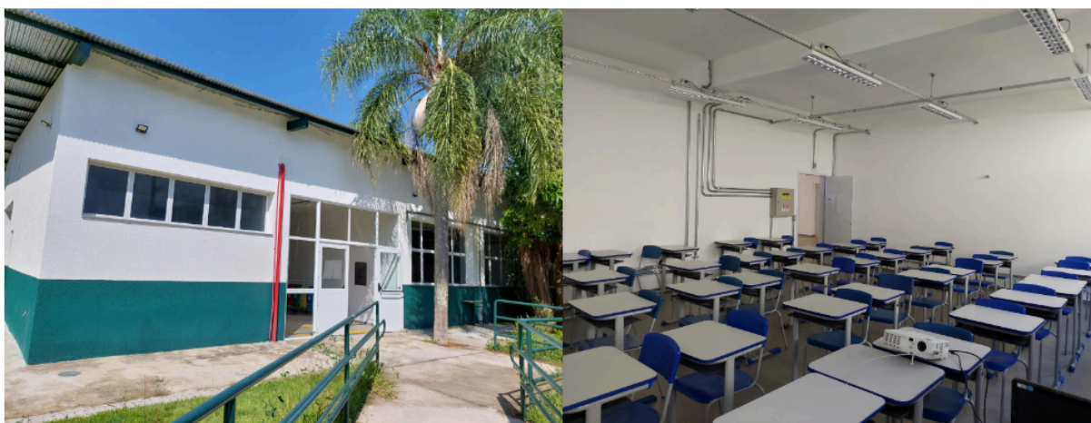
Figuras 1-2 - Vistas interna e externa do bloco escolar e a sala padrão
